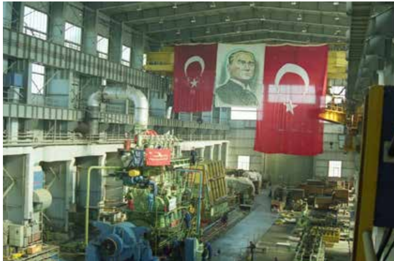
Şekil 53 Pendik Sulzer Motor Fabrikası
